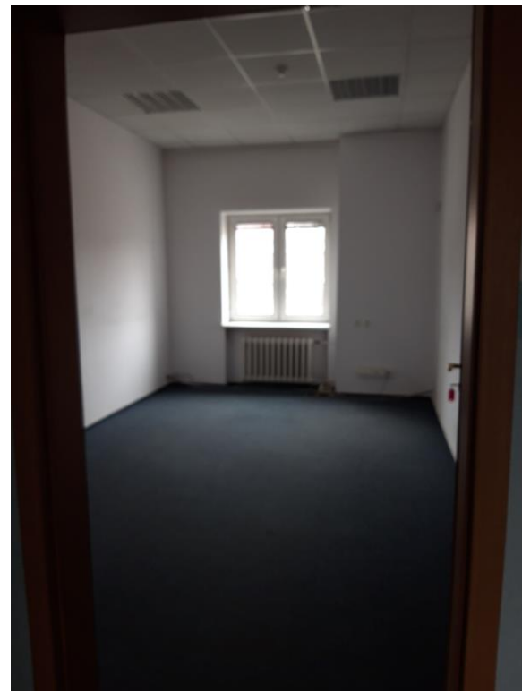
Pomieszczenie biurowe o pow. 18,12 m 2
