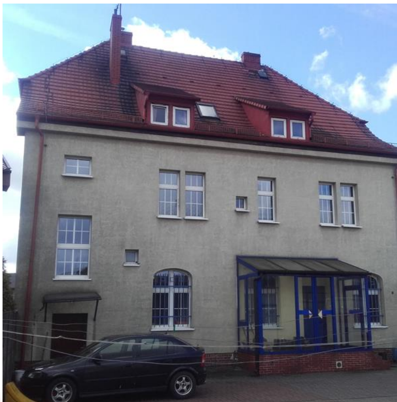
Widok od strony podwórza (wejście do części mieszkalnej – z lewej strony)
