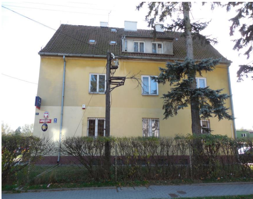
Budynek od strony ulicy w którym znajduje się lokal mieszkalny
